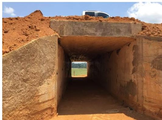
Fotos 14 e 15: Item aditivado: 4.14 – Corpo BSCC 2,50 x 2,50m, e Boca BSCC 2,5 x 2,5m – Bueiro Simples Celular de Concreto próximo à estaca 1979
