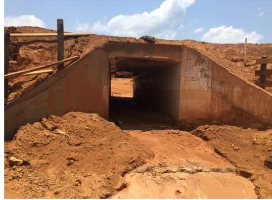
Fotos 2 e 3: Item aditivado: 4.14 – Corpo BSCC 2,50 x 2,50m, e Boca BSCC 2,5 x 2,5m – Bueiro Simples Celular de Concreto próximo à estaca 1583
