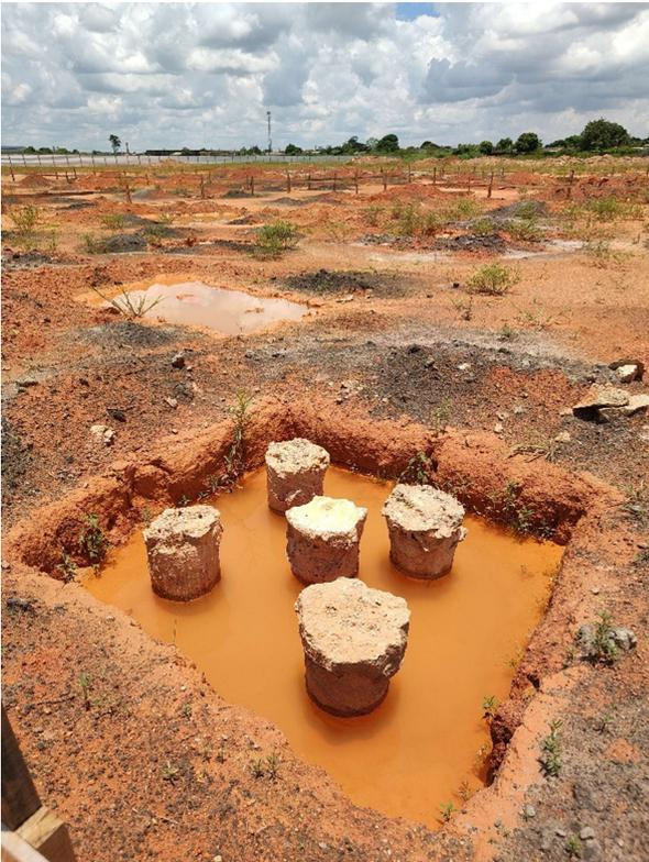
Foto 9 Área I – Estacas sem arrasamento, sem blocos
