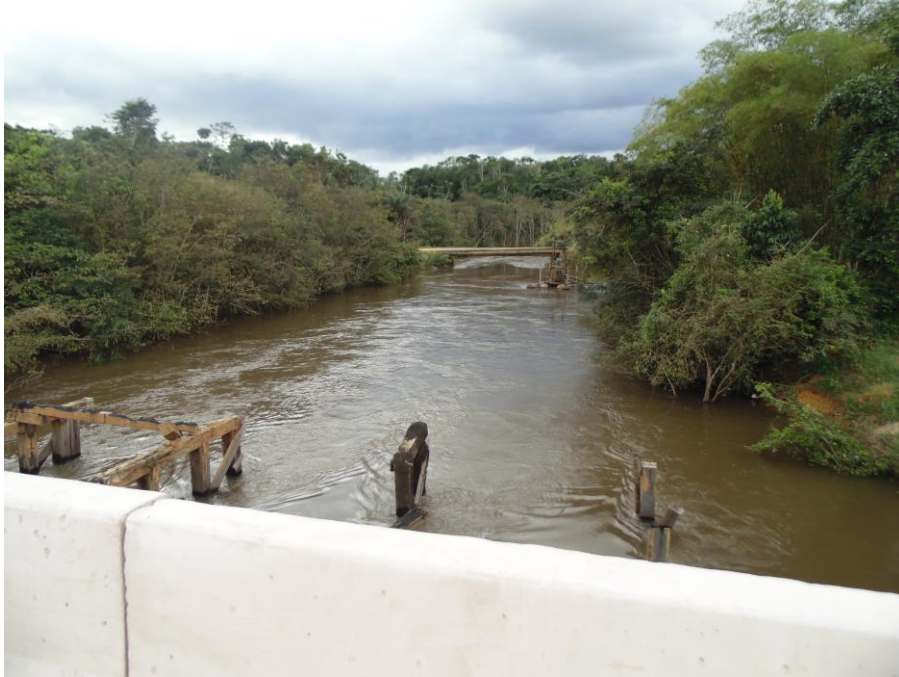
Figura 7. Distância entra a ponte colapsada e a ponte construída pelo DER-RO
