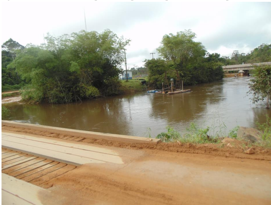
Figura 8. Distância entra a ponte colapsada e a ponte construída pelo DER-RO
