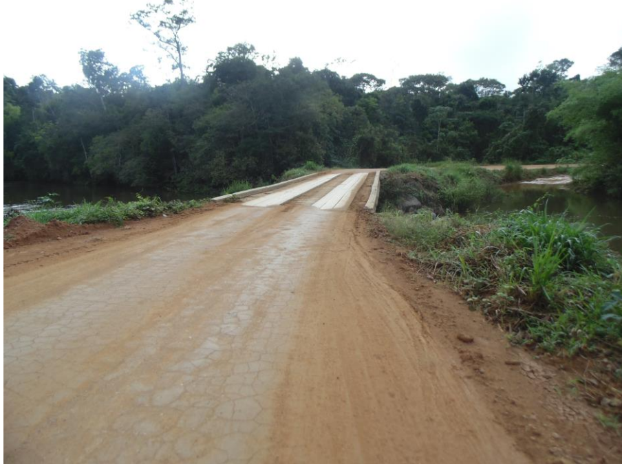
Figura 3. Ponte construída pelo DER-RO
