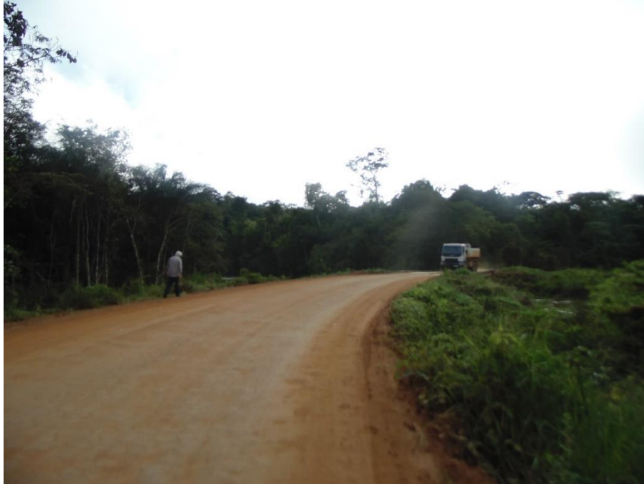
Figura 6. Caminhão passando sobre a ponte construída pelo DER-RO
