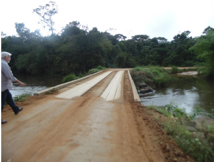
Figura 4. Ponte construída pelo DER-RO
