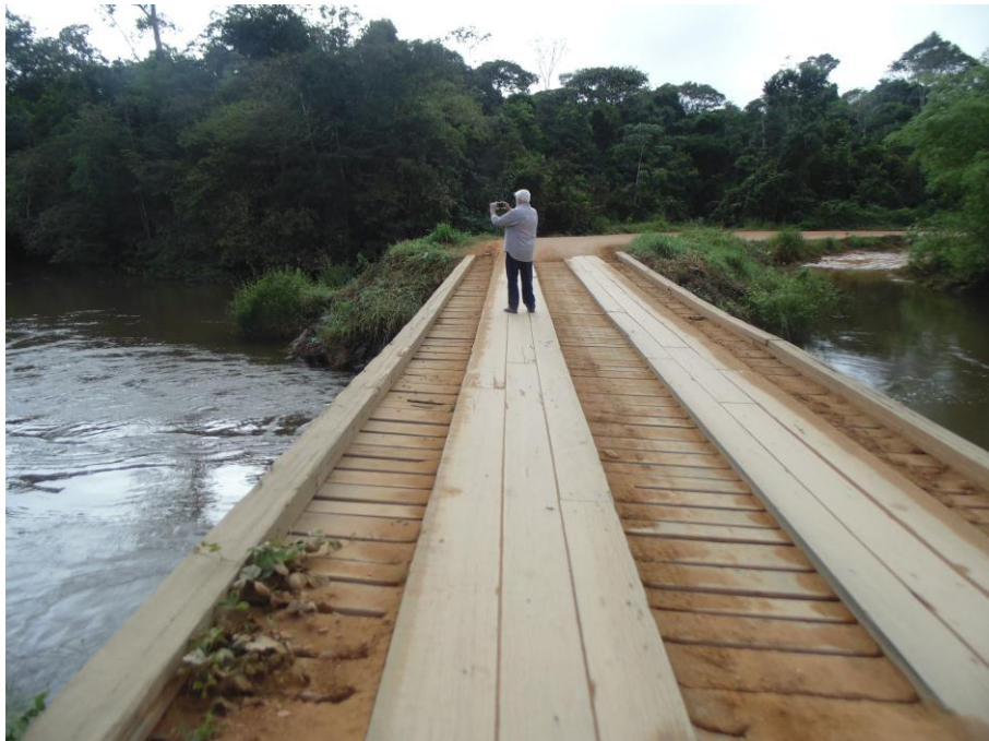
Figura 5. Ponte construída pelo DER-RO
