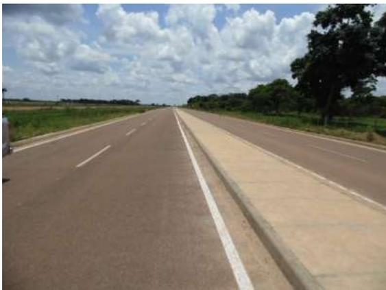
Foto 49 (esq.): Detalhe do piso em concreto no canteiro da pista dupla do acesso a Pimenteiras, sentido Entº. RO-370.
