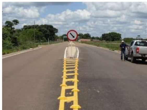
Foto 45 (esq.): Detalhe da Lombada (para diminuir a velocidade), antes da bifurcação da pista do acesso a Pimenteiras.
