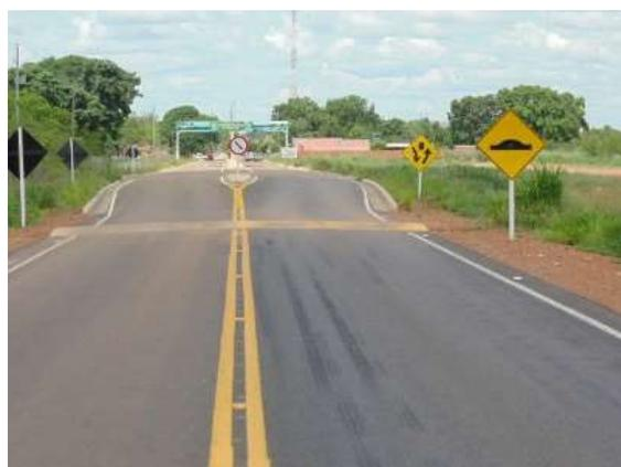
Foto 43 (esq.): Detalhe do Sonorizador (para alertar os motoristas), Estaca 1830, sentido Pimenteiras.
