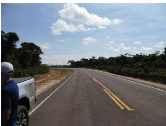
Foto 19 (esq.): Detalhe da outra curva, após a saída para a Linha 10, sentido: Pimenteiras, nota-se a falta de sinalização.
