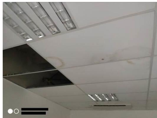
Fotos 5 e 6: Subsolo – Infiltração Sala Gerenciamento e forro inacabado
