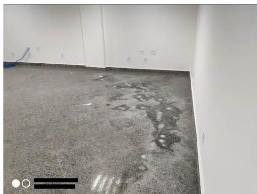
Fotos 3 e 4: Subsolo – Infiltração, acúmulo de água e forro inacabado Sala Gerenciamento
