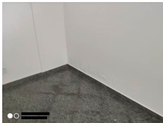
Fotos 1 e 2: Subsolo - Infiltração na Sala Arquivo Deslizante
