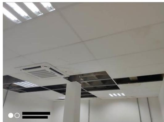
Fotos 9 e 10: Subsolo – Infiltração, acúmulo de água e forro inacabado Sala Gerenciamento
