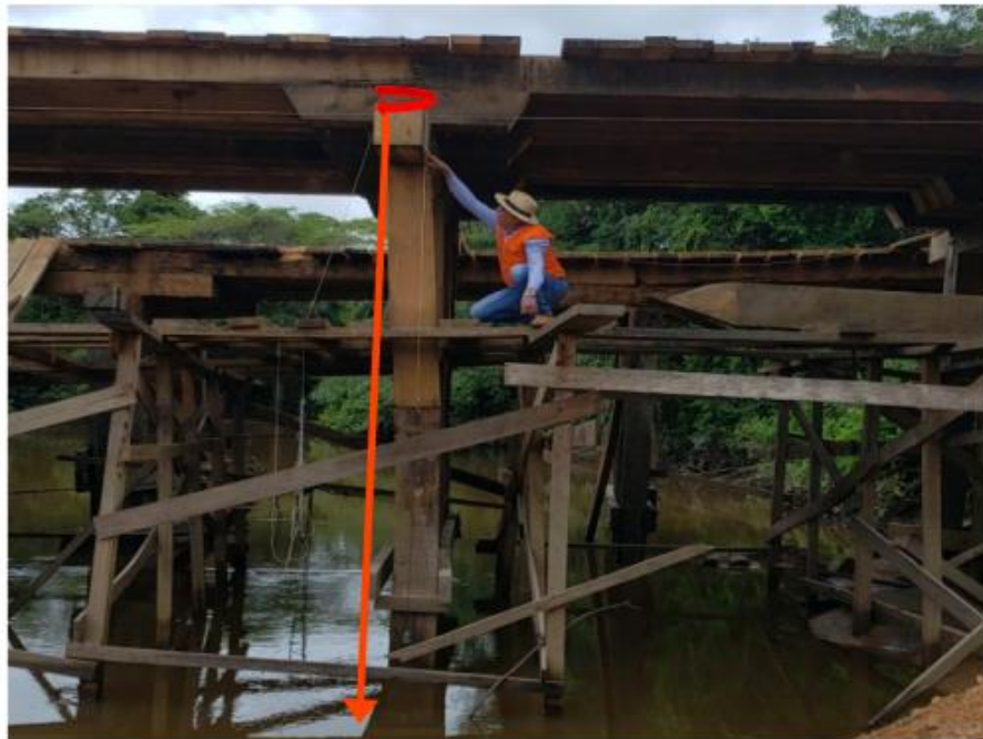
Foto 9 – Outro local com o prumo ratificando a estaca fora de alinhamento
