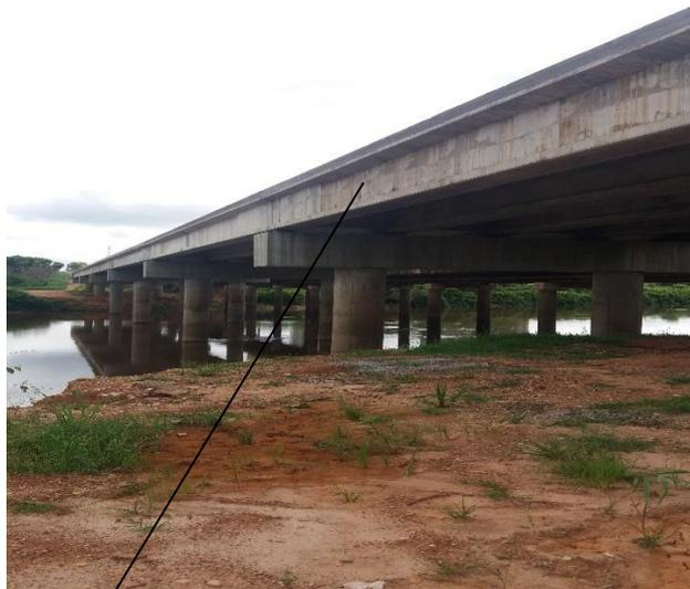
Vista frontal e lateral da ponte, verifica-se a não execução do aterro e laje de transição.
