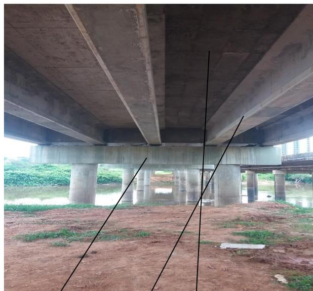
Vista inferior da ponte, ver pilares, vigas transversinas, longarinas, laje.
