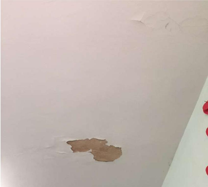
PT-06. Itens 5.8 e 5.9. Teto da sala de aula com sinais de infiltração, pintura com bolhas e descascados.
