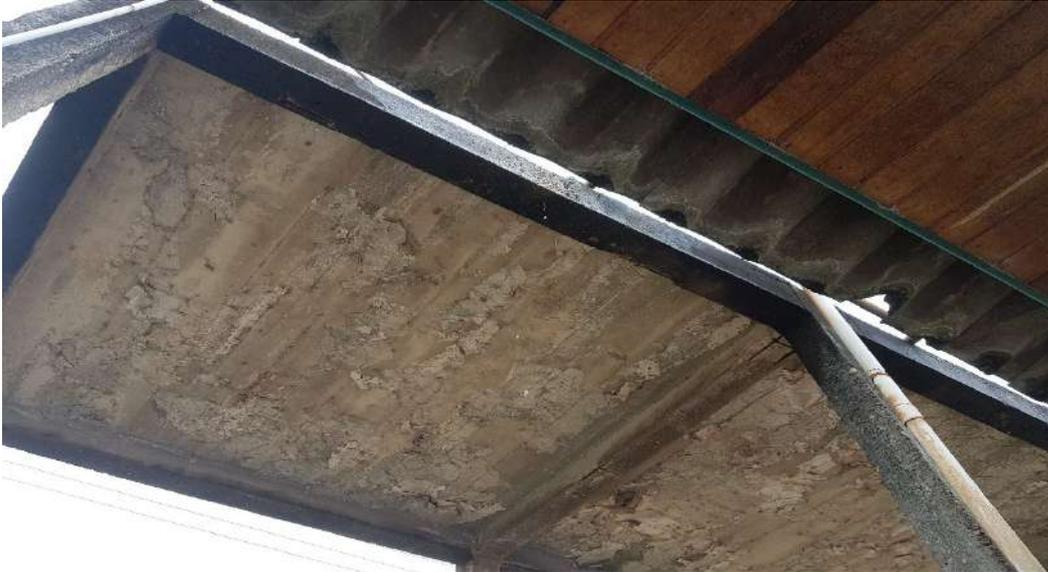
**PT-01. Item 6.33. Vazamentos na Caixa D'água**
