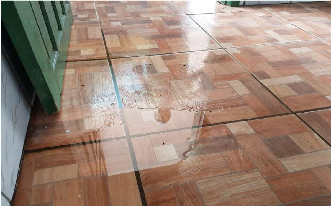
**PT-01. Item 6.19. Água da descarga escorrendo pelo banheiro masculino devido a infiltração do vaso sanitário**
