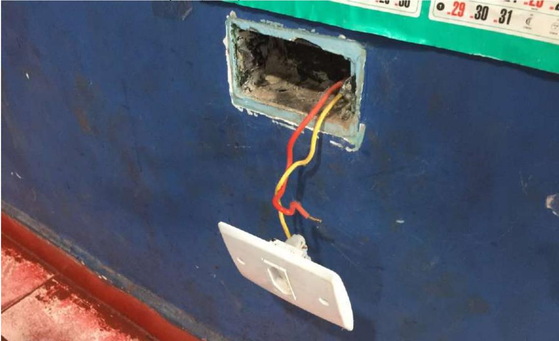
**PT-04. Itens 5.2 e 5.3 (Espelho da tomada solto, fiação exposta e fio desencapado).**
