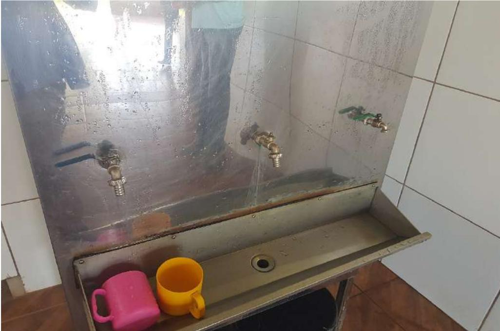
**PT-01. Item 6.30. Bebedouro com torneira danificada e com vazamento.**
