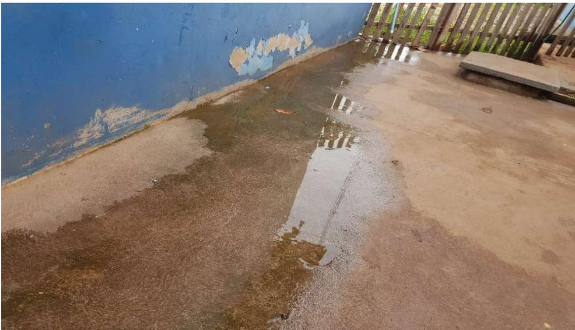
**PT-01. Item 6.26. Infiltração (piso/parede) e vazamentos**
