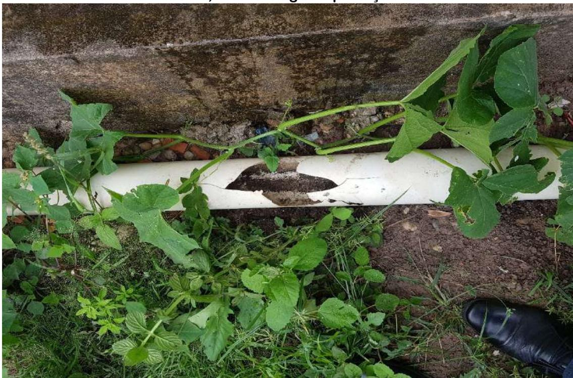
**PT-01. Item 6.34. Cano do esgoto quebrado com vazamento**
