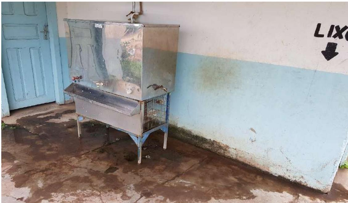
**PT-01. Itens 6.26 Infiltração (piso/parede) e 6.33. Vazamentos no bebedouro**
