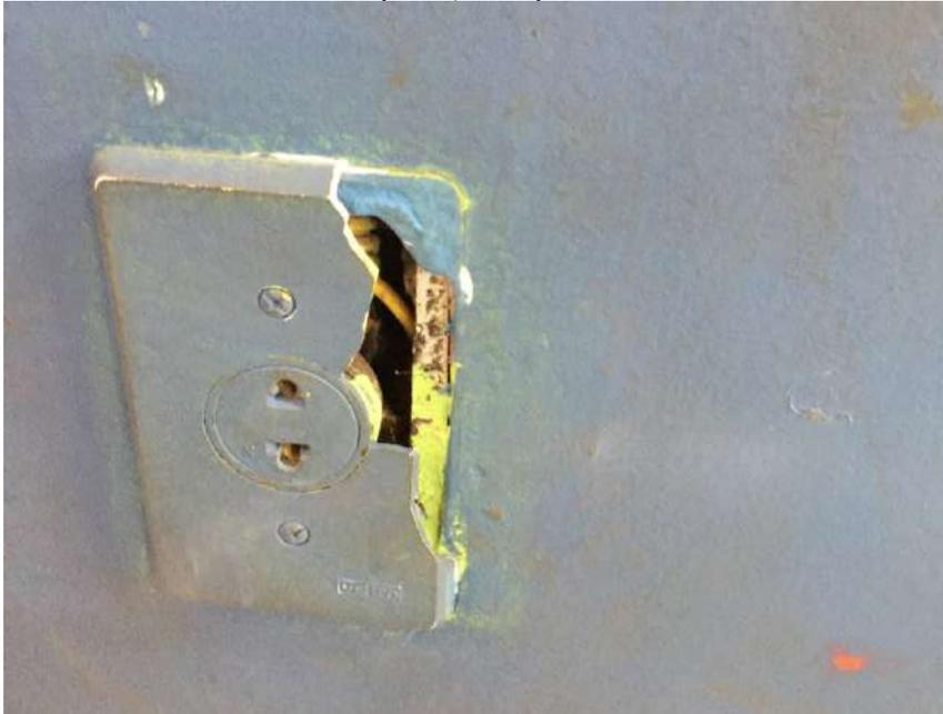
**PT-04. Itens 5.2 e 5.3 (Espelho da tomada quebrado e fiação exposta).**
