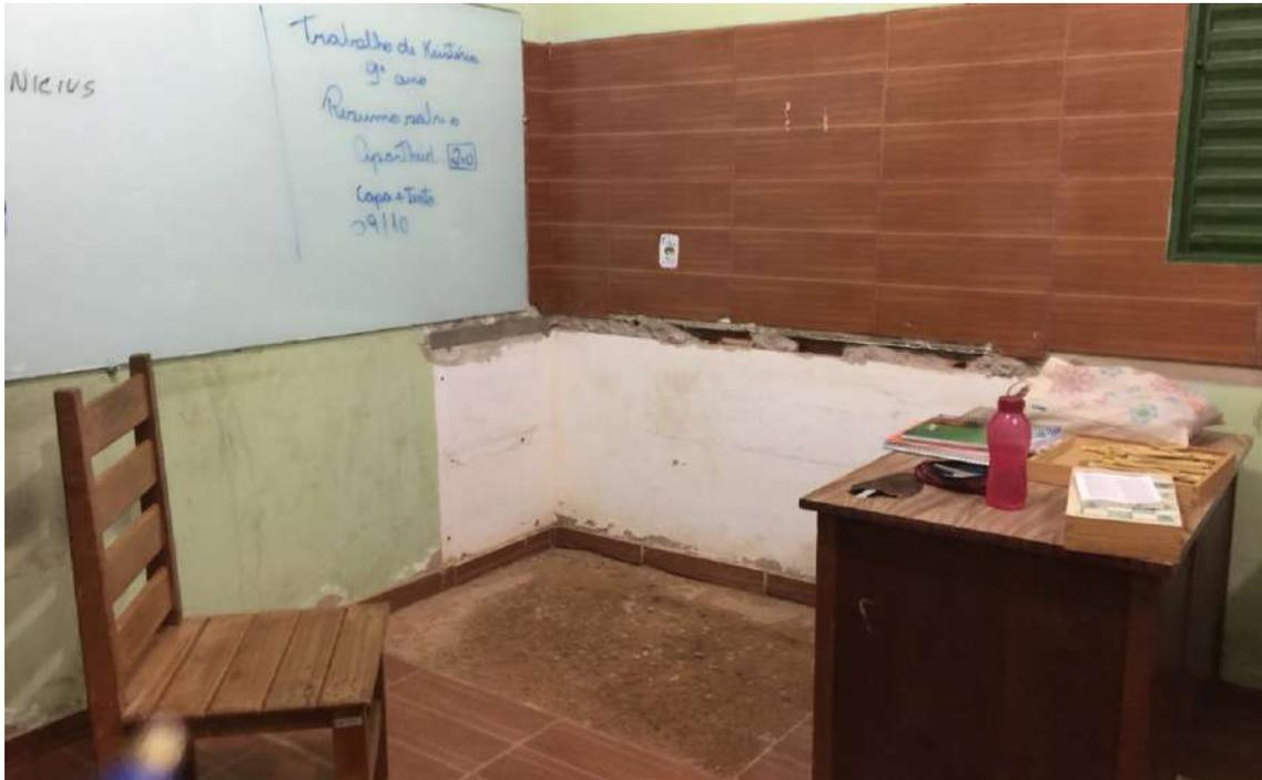
**PT-06. Itens 5.5 e 5.7 (Piso com desnível e liberação de fragmentos; buracos na parede).**
