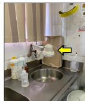
Figura 45 – Instalação de chuveiro na pia.
