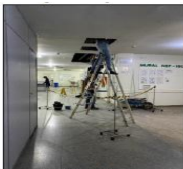
Figura 25 – Substituição do esponjoso do ar-condicionado da área de circulação do 2º andar.
