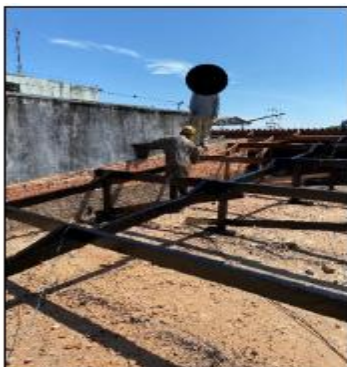
Figura 27 – Aplicação de imunizante para madeira
