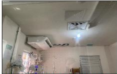
Figura 18 - Forro de gesso no leito de isolamento na UTI
