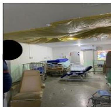
Figura 16 – Forro da enfermaria G
