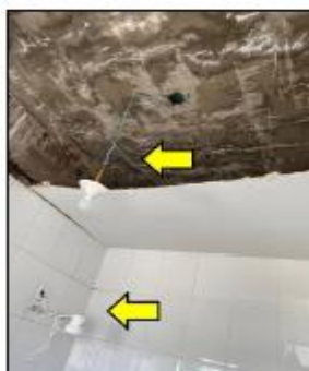
Figura 43 – Banheiro da enfermaria K
